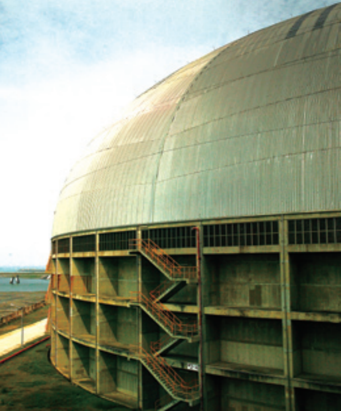
▲室內煤倉之外觀
