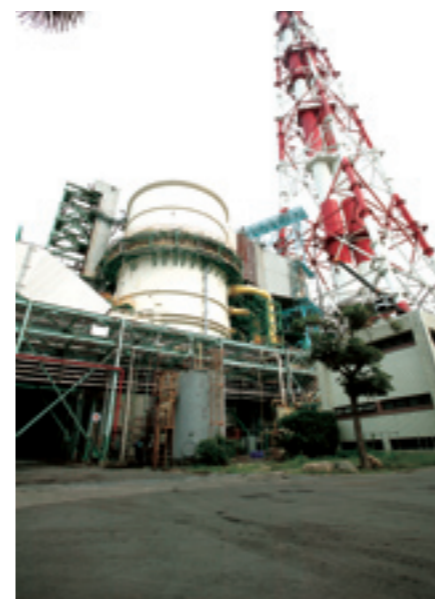
▲經過去硫程序的煙氣，透過右方的煙囪排放
