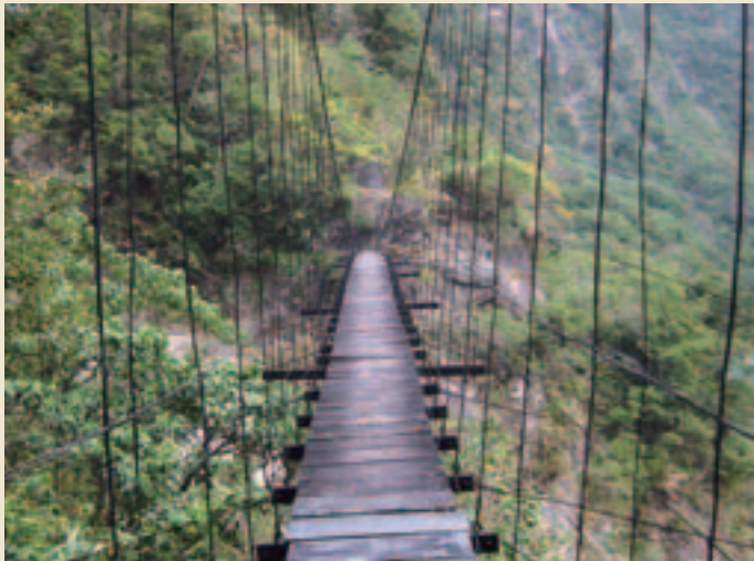
▲ 台電人員鋪設的手工吊橋
