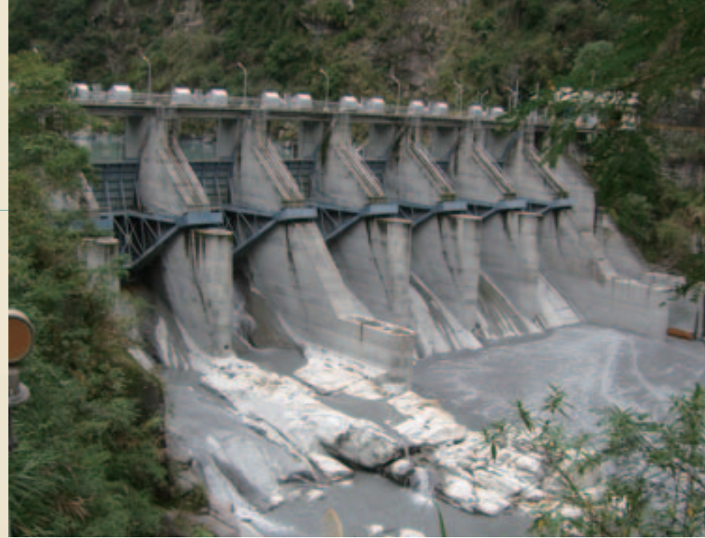
◀ 溪畔壩引水進入立霧電廠
